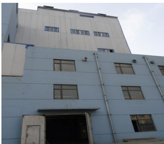
50t/h 锅炉房照片
