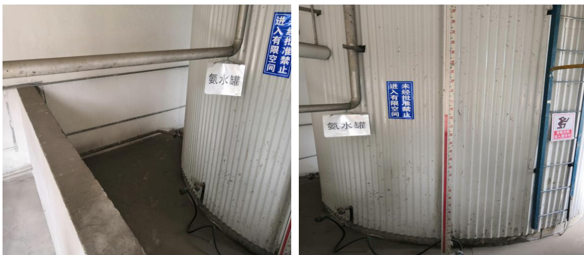
氨水储罐液位仪
