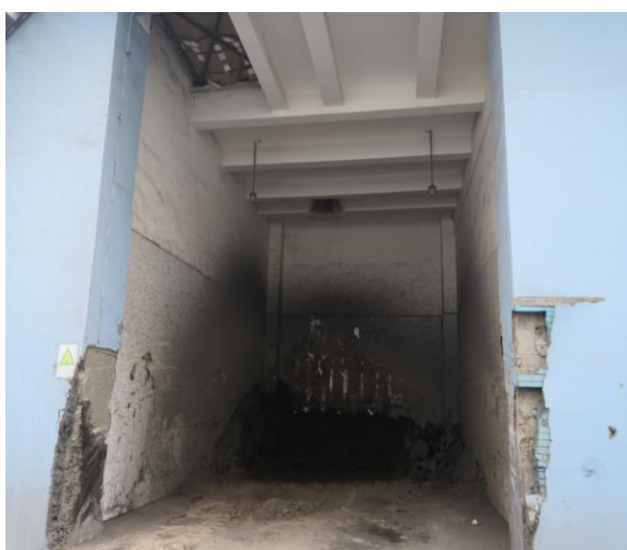
脱硫废渣暂存间
