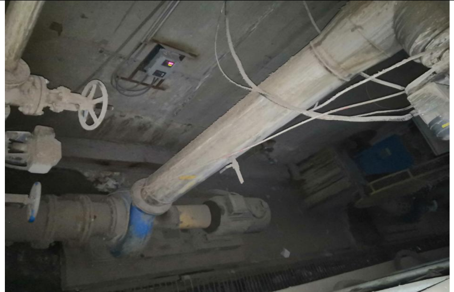
制浆车间纸造纸车间纸浆泵
