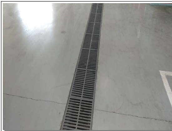
维修车间地面排水沟
